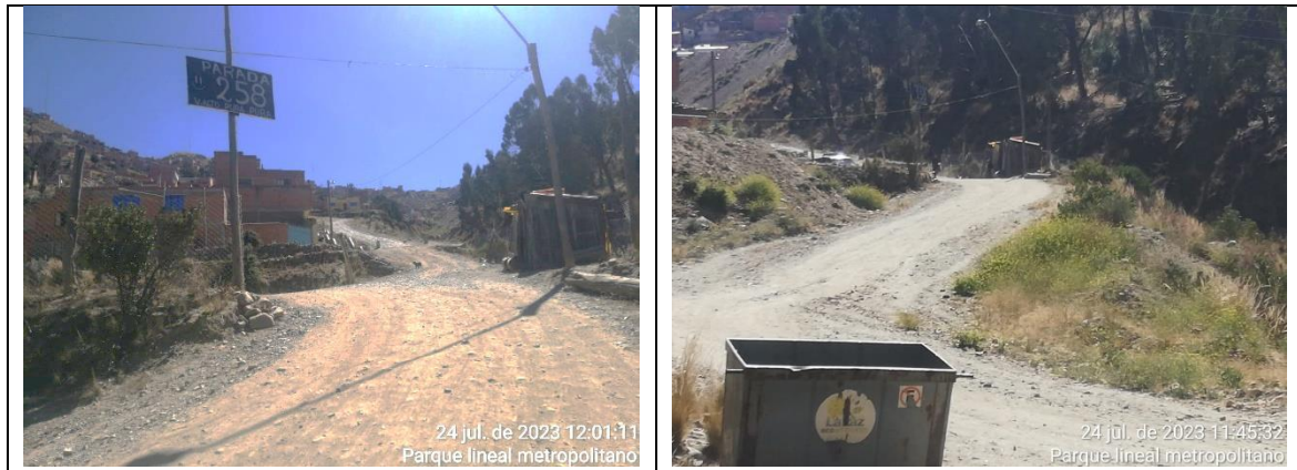
Fuente: Inspección en campo, 2023
