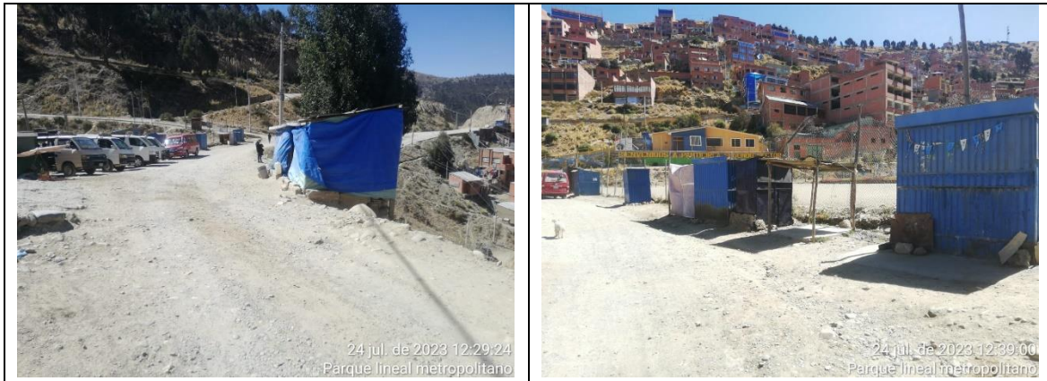
Fuente: Inspección en campo, 2023
